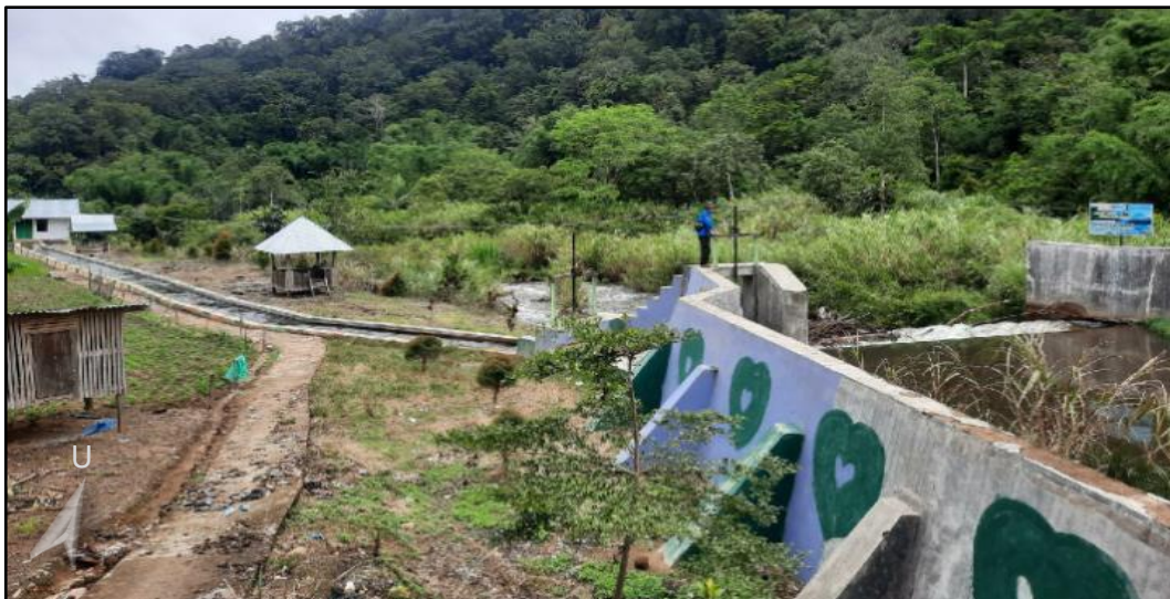
Gambar 34. Pembangkit Listrik Tenaga Mikro Hidro (PLTMH) di Desa Rantau Kermas
