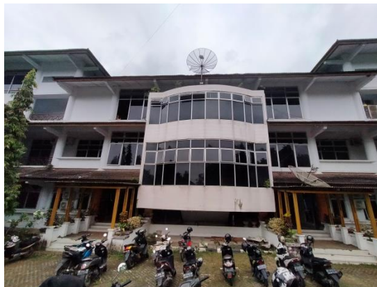
Gambar 3.1 Gedung Rektorat Universitas Jambi (sumber : Data Penelitian 2021)
