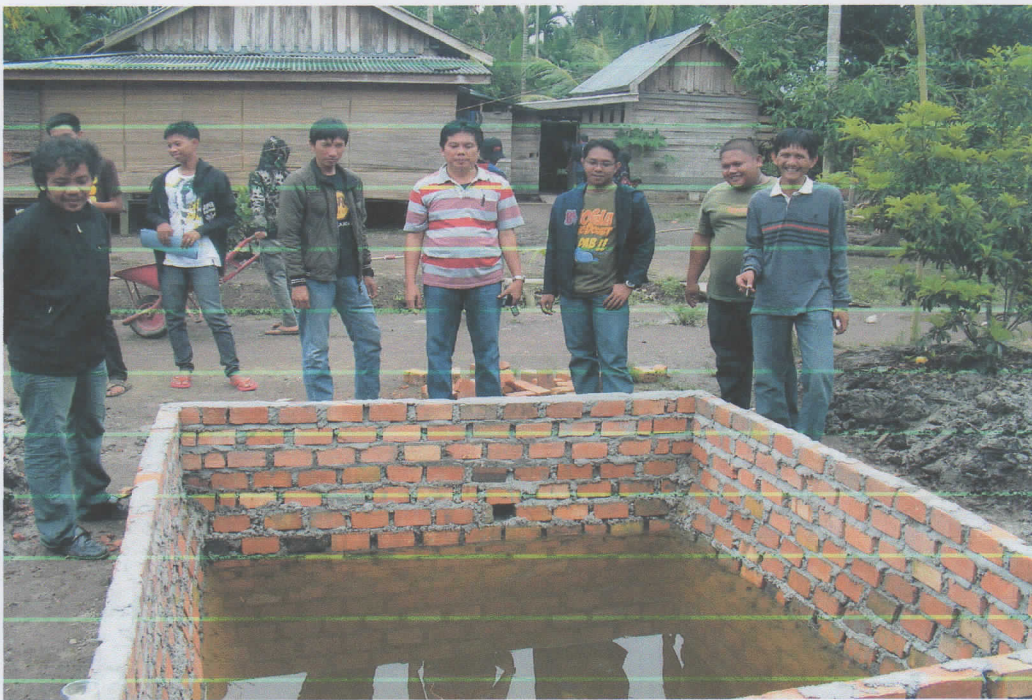
Gambar Air Baku untuk TTG Pengolahan Air Gambut Menjadi Air Bersih di Pesantren AL-Anwar Teluk Serdang
