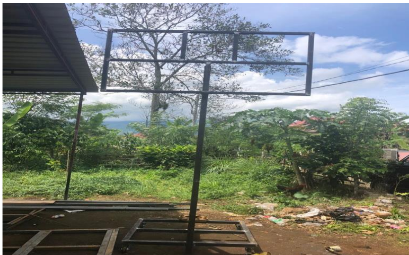
Gambar 4.3 Bagian dasar penyangga Sebelum di Revisi
