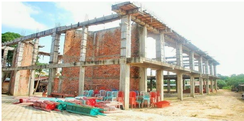
Gambar 1.1 : Bangunan Gereja HKBP Syalom Aur Duri Kota Jambi 2016
