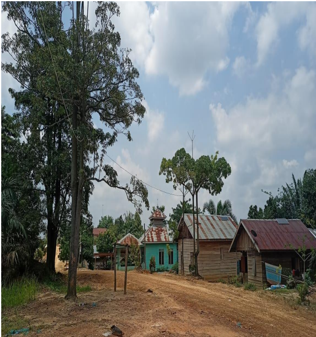
Gambar 19. Lokasi Perencanaan Pembangunan PLTS (sumber : dokumentasi pribadi)
