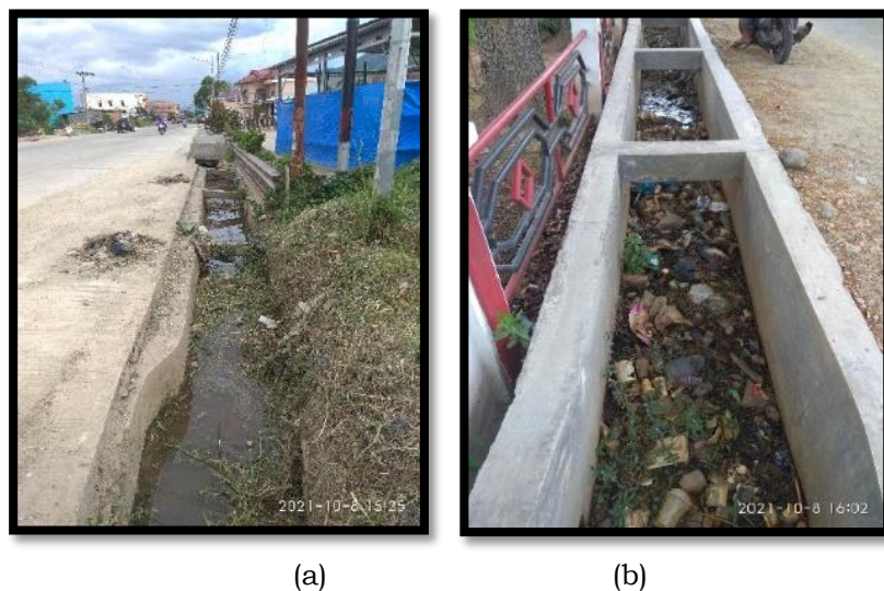
Gambar 11. Saluran drainase (a) lokasi 1, (b) lokasi 2
