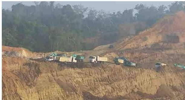
Gambar 4. Antrian Alat Angkut pada kegiatan pengupasan overburden
