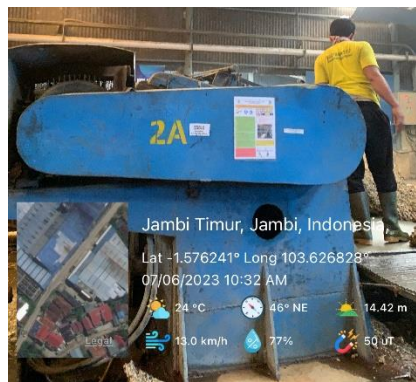
Gambar 4.8 Dinding (Cover) Peredam Kebisingan
