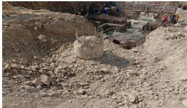
Gambar 4.1 Fondasi Bored Pile pada Gedung MICE Sumber: Data Umum Proyek, 2022
