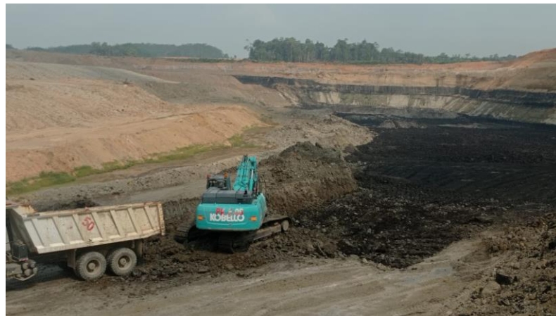
Gambar 14 Kondisi Area Overcut di Lapangan
