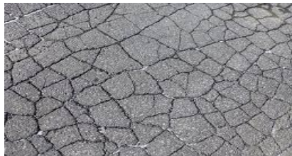
Gambar 2.3 Retak Kulit
