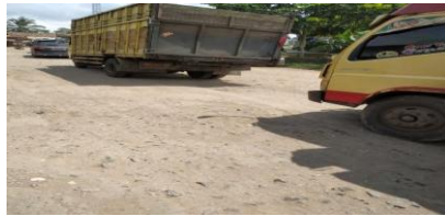
Gambar 3.3 Kondisi Jalan (Sumber :Hasil survey, 2022)
