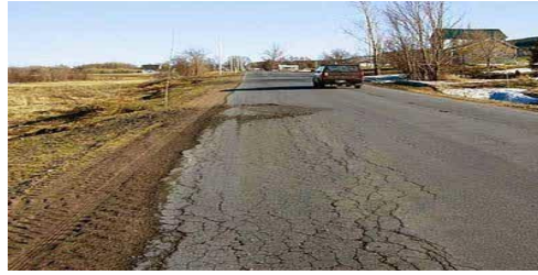
Gambar 2.4 Retak Pinggir
