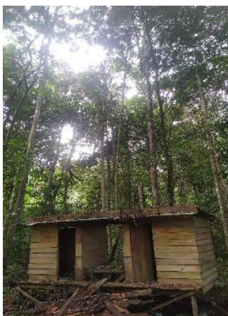
Toilet Hutan Desa Pematang Rahim
