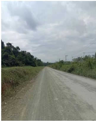
Jalan Menuju Hutan Desa Pematang Rahim
