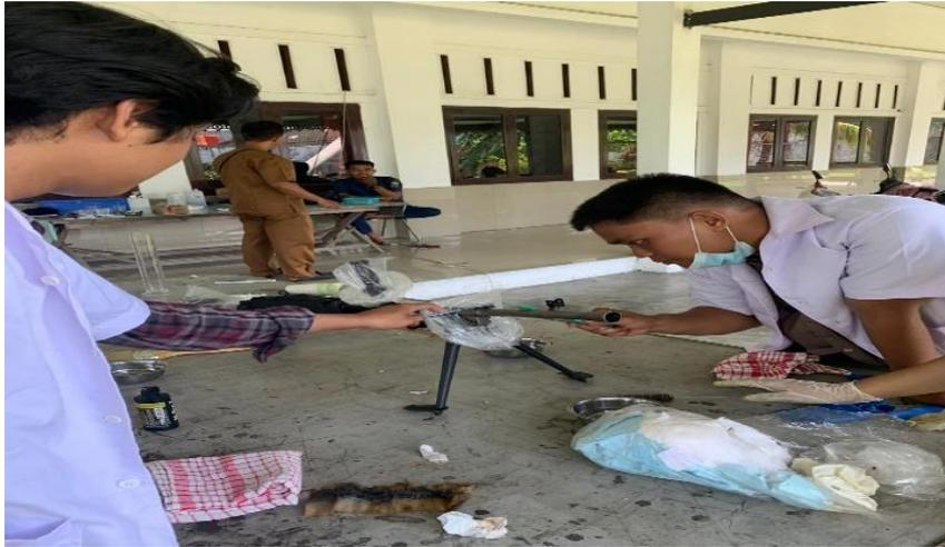
Foto 3. 13: pembersihan menggunakan zat kimia untuk bagian berbahan kayu di tutupi plastik
