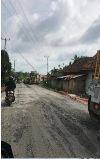
Foto ini menunjukkan jalan dari Desa Tangkit menuju Desa Sungai Gelam pada saat pekerja perbaikan jalan melakukan pengerasan.
