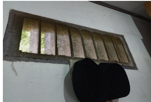
Gambar 4 Terdapat kawat kasa pada ventilasi di rumah responden
